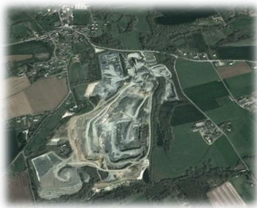
Photographie aérienne de la carrière de Pont-Illis
